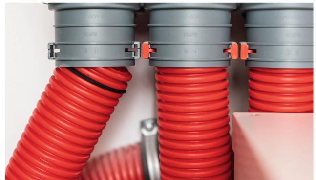
**Problem:** Nicht korrekt befestigte Leitungen verhindern den ordnungsgemäßen Betrieb. Der falsche Luftaustritt /-eintritt wirkt sich auf die Leistungsfähigkeit der Anlage aus.
