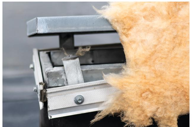
**Problem:** Durch das Verschließen des Abluftschachtes mittels Dämmwolle wird die Funktion der Lüftungsanlage beeinträchtigt.
